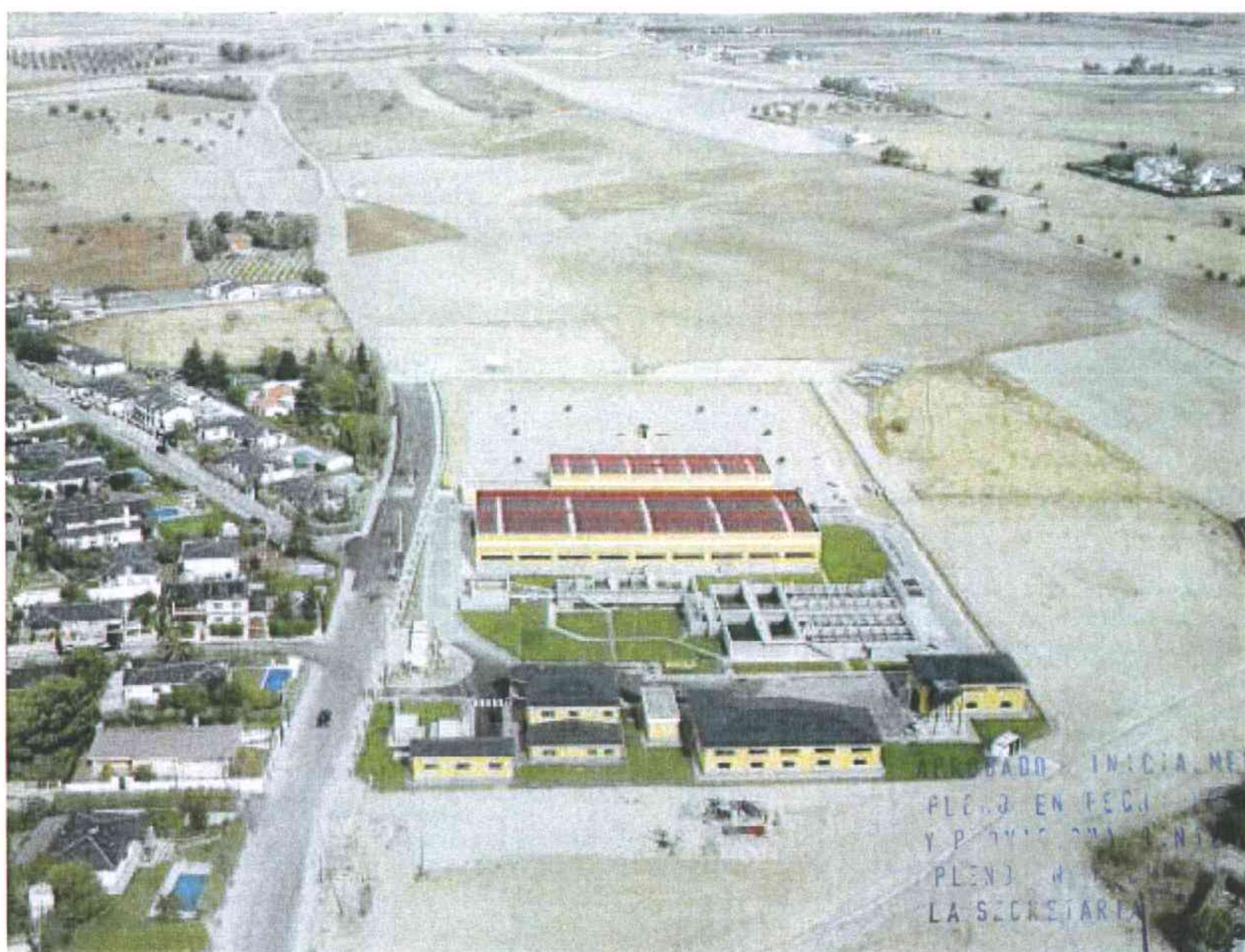
Ilustración 4. Estación de Tratamiento de Agua Potable Griñón - Madrid. Año 2007.
