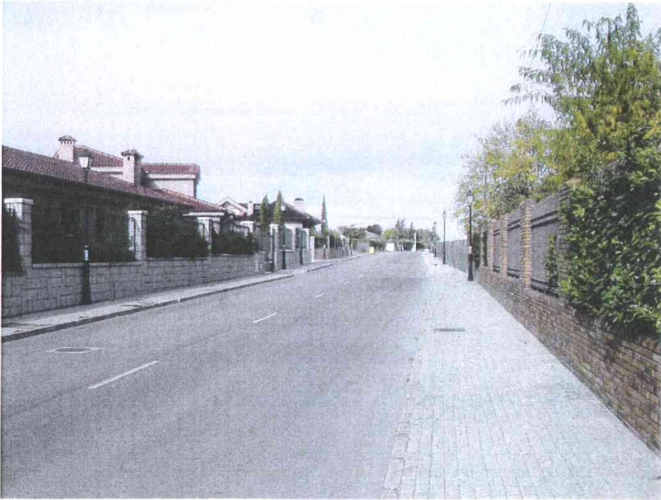
Ilustración 14. P. 05. Punto de observación en la intersección de la calle Olivar del Patrón con la calle La Rosa. Vista en la calle Olivar del Patrón hacia la ETAP Griñón – Madrid.
