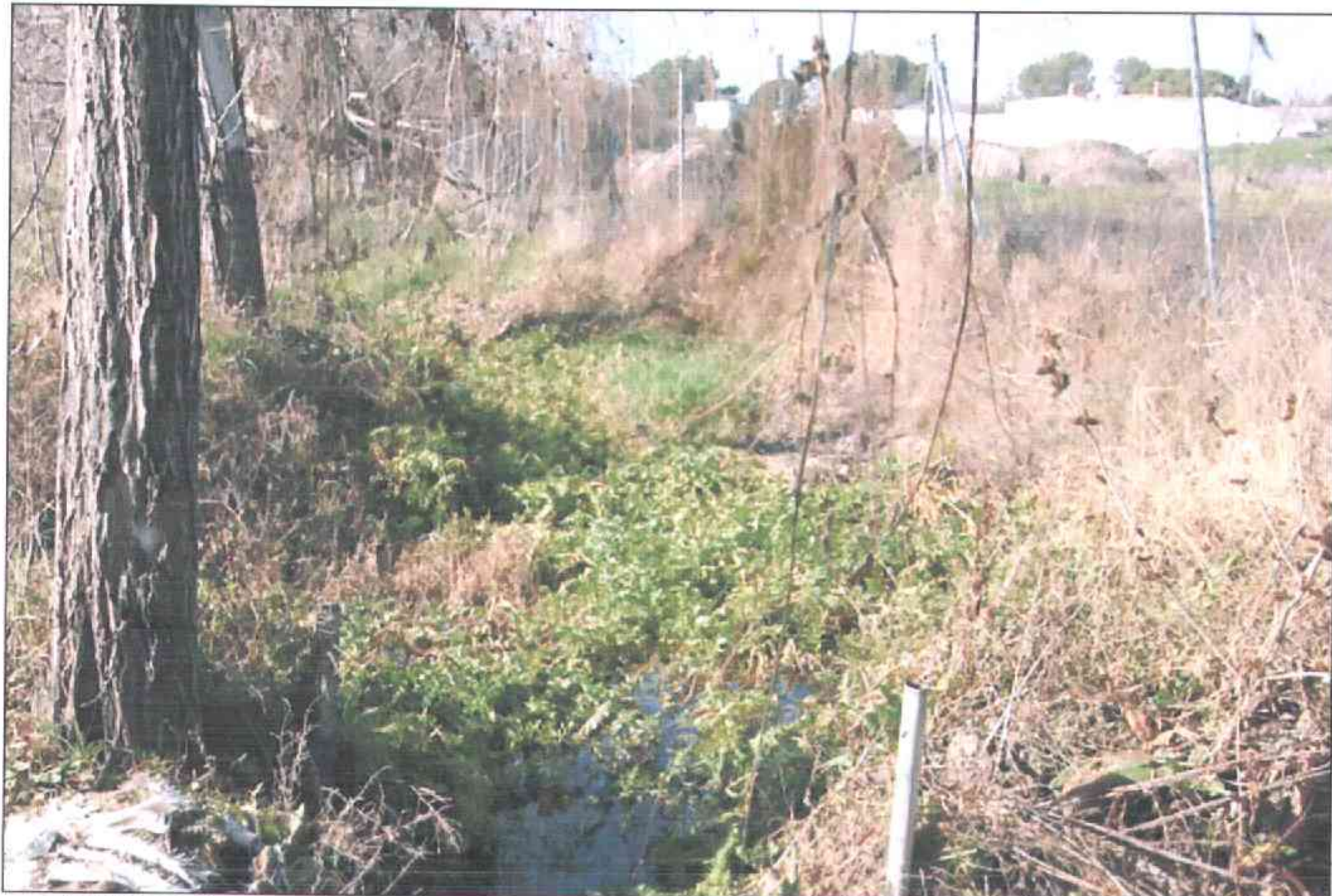
FOTO 5. Arroyo de las Arboledas en la zona donde se prevé incorporar las aguas de lluvia de la nueva actuación. Vista hacia aguas arriba
