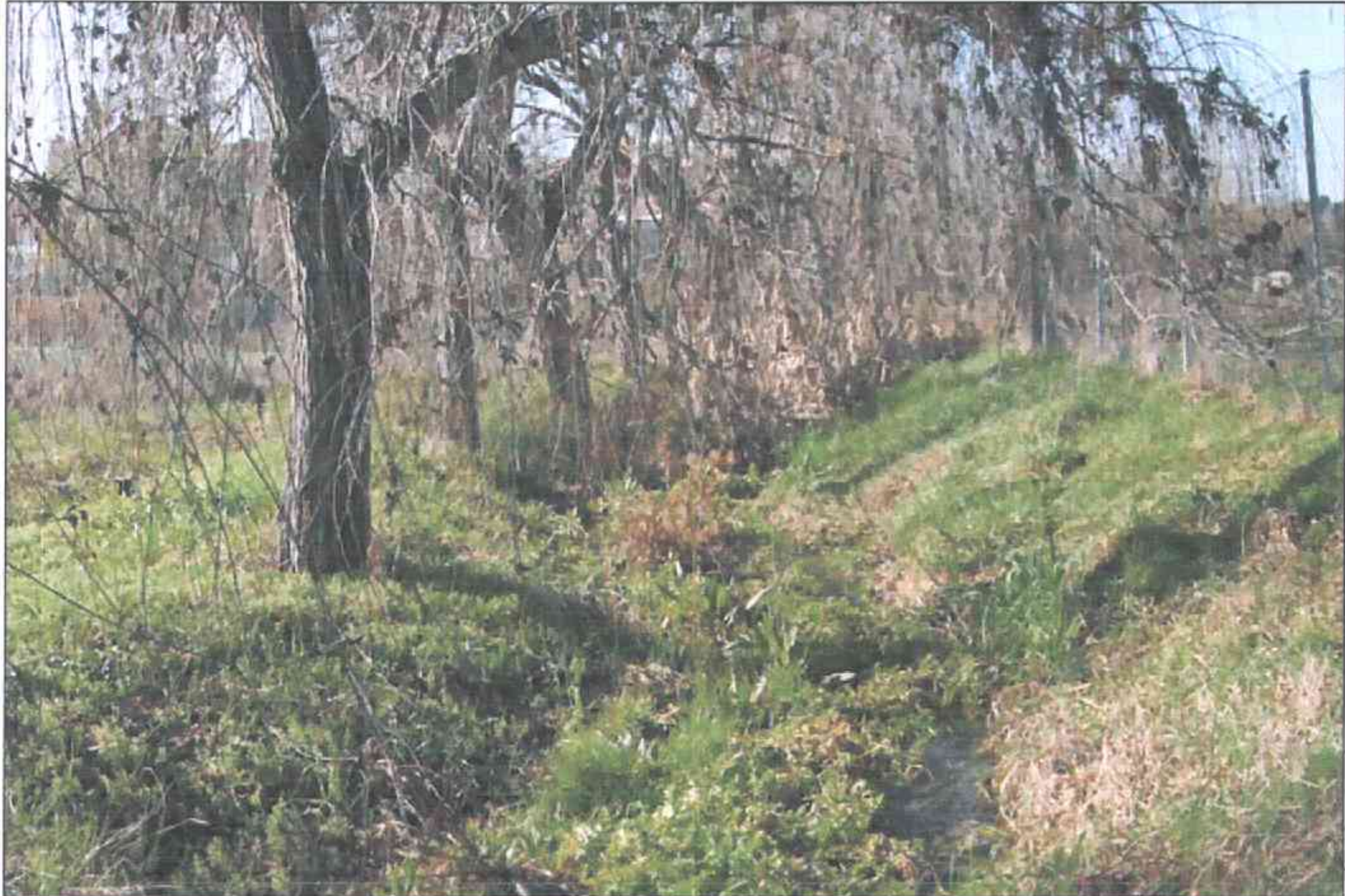
FOTO 3. Arroyo de las Arboledas. Vista hacia aguas arriba.
