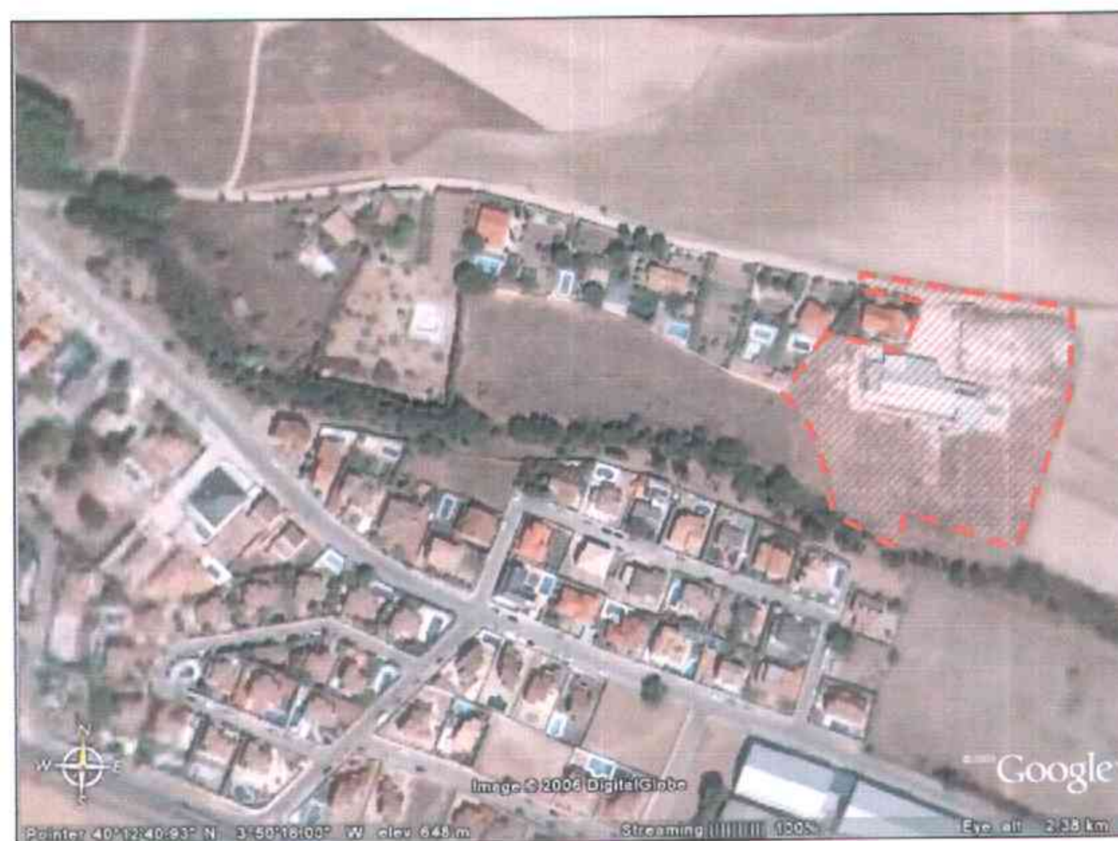
FOTO 1. Vista aérea estado Actual.
