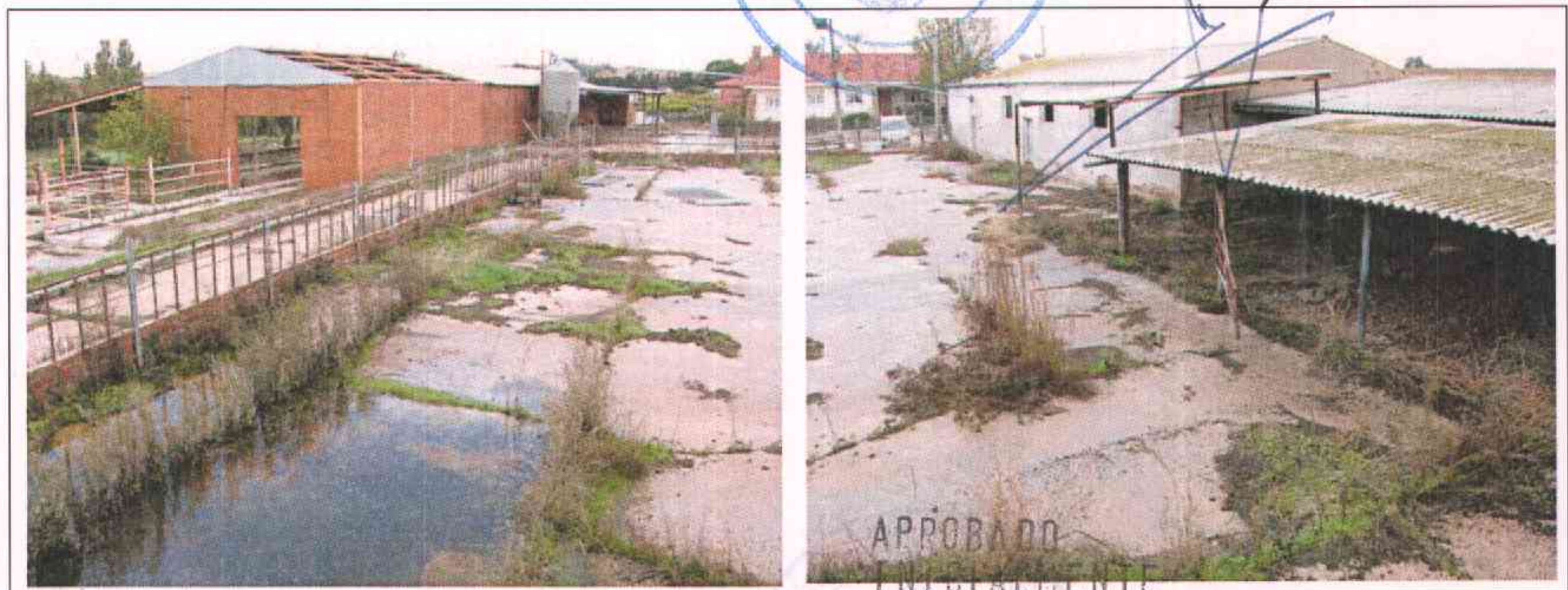
Fotos 9 y 10. Vistas de diferentes zonas de las instalaciones que permanecen en pie (nótese la pavimentación con solera de hormigón del suelo)
