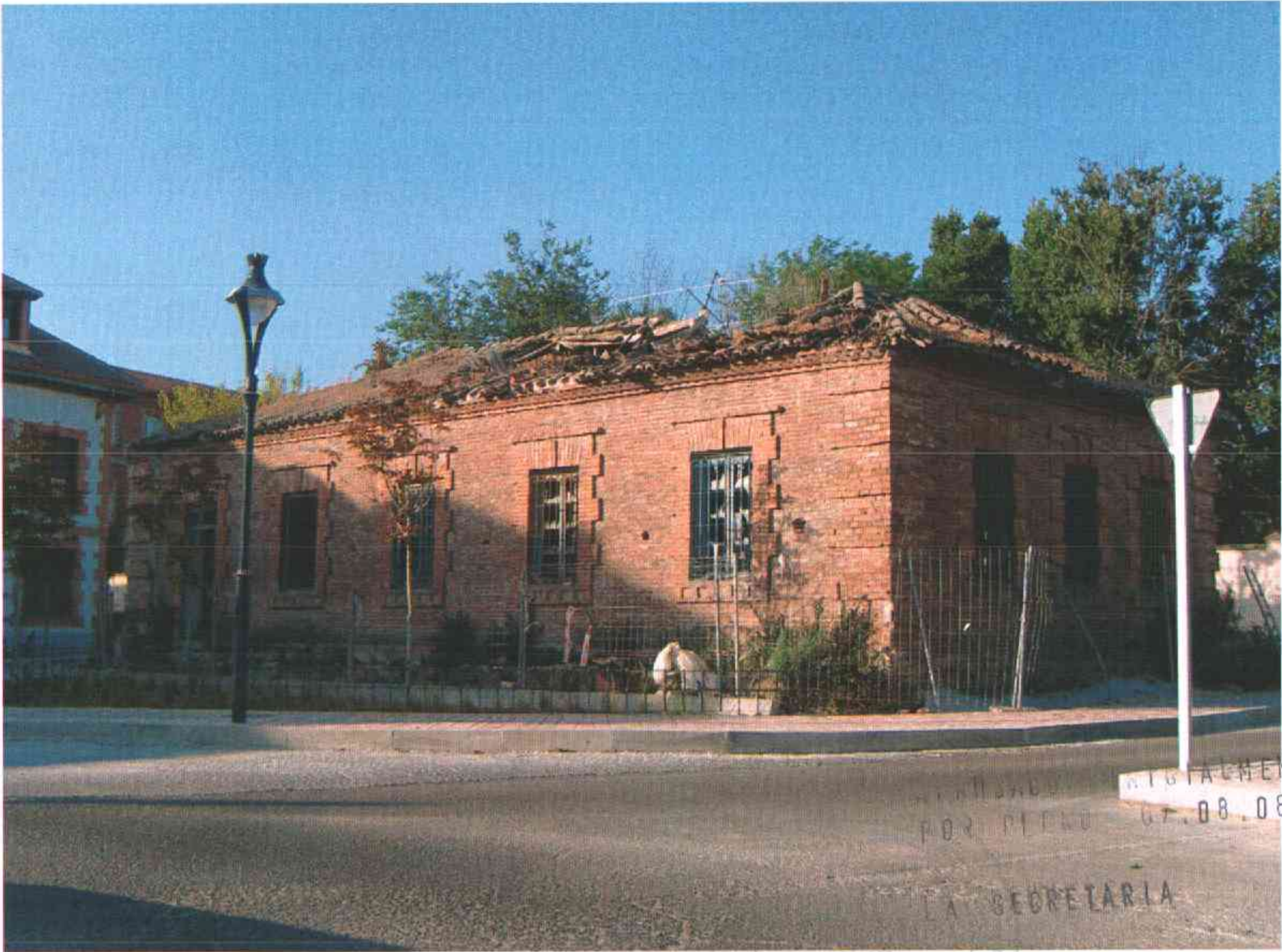
Vista fachadas norte y oeste y cubierta
